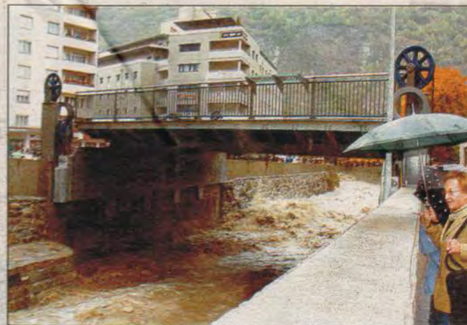
Die Saltina-Hubbrücke als wichtiges Thema der Exkursion «Hochwasser Saltina».
