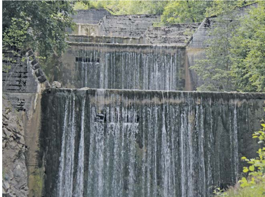
Betonsperren im steilen Oberlauf der wilden Gürbe.
