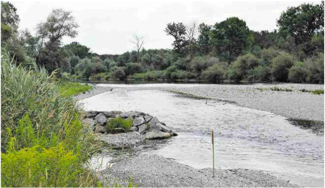
Das Biberäuli mit einer Buhne, welche die Strömung Richtung Flussmitte lenkt.
