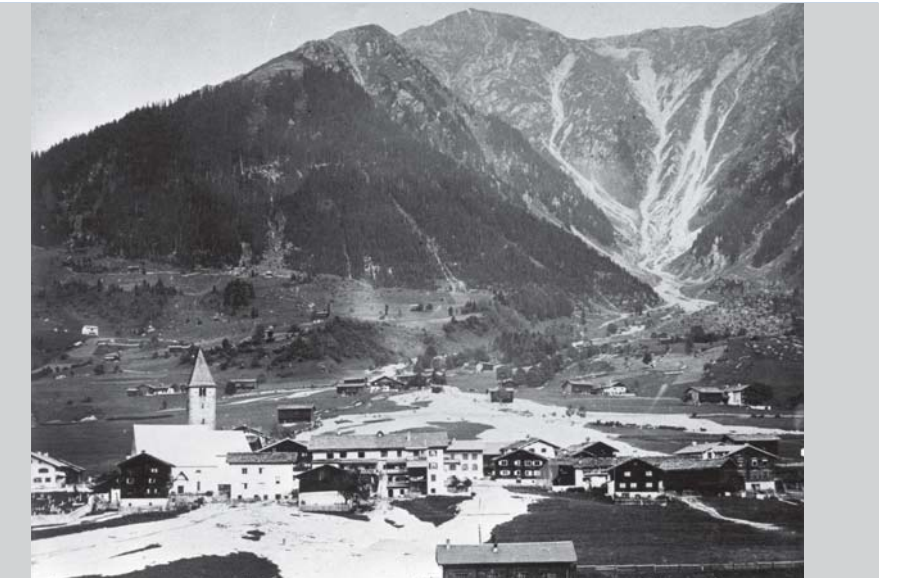
Fig. 1: Inondation dynamique et coulée de boue à Klosters Platz GR. En arrière-plan, le bassin versant du Talbach (photo: Amt für Wald und Naturgefahren Graubünden, 21.7.1900)
