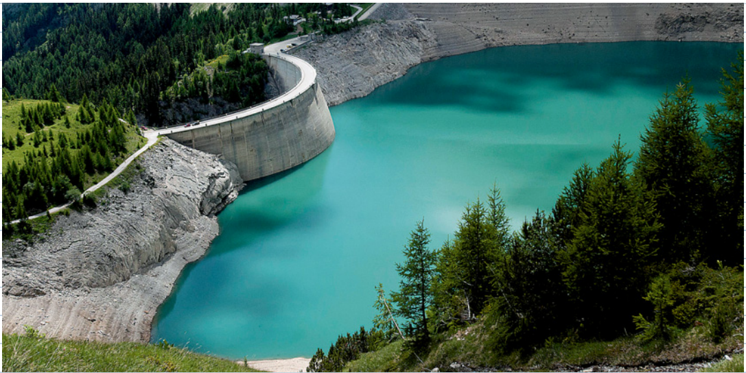
Fig. 6 : Le lac de barrage de Tseuzier à 1800 m – la société Electricité de la Lienne SA a obtenu en 1957 la concession l’autorisant à utiliser l’eau pour produire de l’électricité jusqu’en 2037. (photo : Emmanuel Rey)
