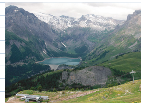
Fig. 5: Lac de barrage de Tseuzier (1800 m), d'une capacité de 50 millions de m 3 d'eau (photo: Hanspeter Liniger)
