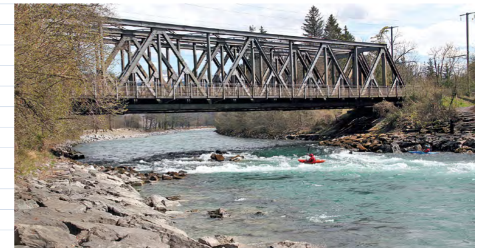
Fig. 2 : L'Aar au niveau du pont d'Uttigen en 2020 : la rivière a été canalisée au XIX e siècle et dotée d'un seuil au XX e siècle. (photo : Matthias Probst)
